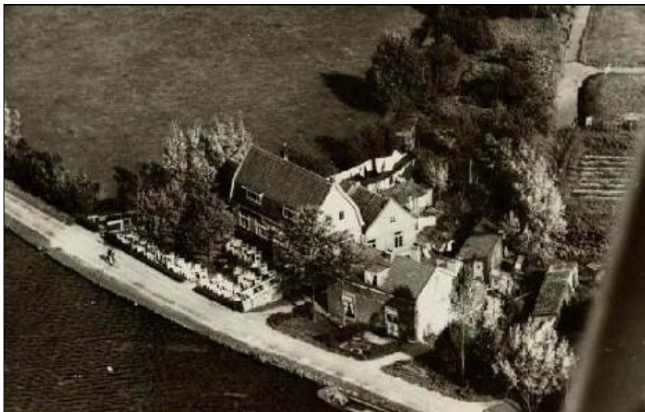
6 Ouderkerkerdijk 200-204 (foto SAA, ongedateerd)
