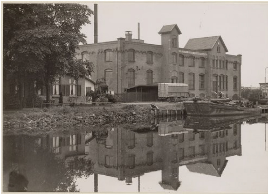
Afbeelding 3: De voormalige chemische fabriek in 1933, overgenomen door de broers Biederman om er de Cinetone Studio's te vestigen (foto SAA)
