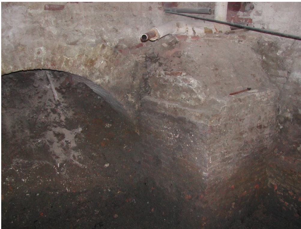
15 Fundering van de 17de-eeuwse schepradmolen onder het gerestaureerde Flevogemaal (bron: website Stadsherstel)
