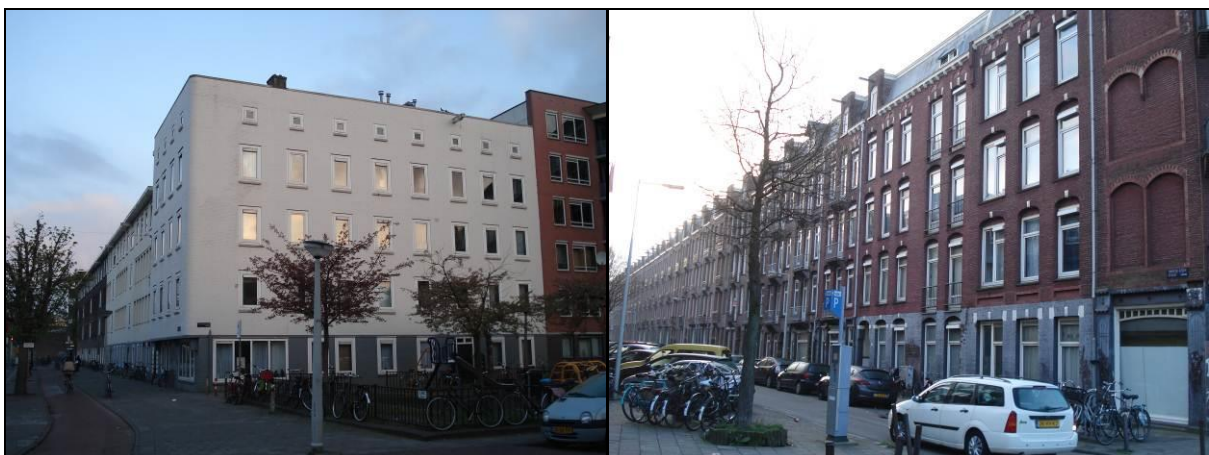
Afbeelding: bebouwing op de hoek Riouwstraat/Insulindeweg (links) en Tweede Atjehstraat (rechts)
