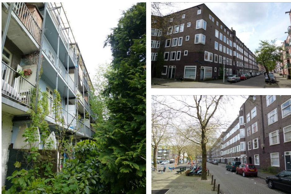
indrukken van het plangebied; de achterzijde van de gebouwen aan het Sumatraplantsoen (links) en twee indrukken van de voorzijde (Sumatrastraat en Sumatraplantsoen) van de gebouwen (rechts)
