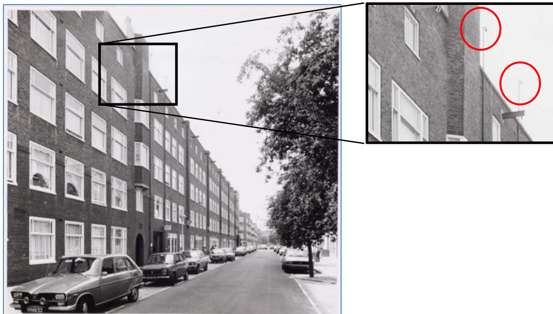
Figuur 1: Ontluchtingspunten ondergrondse tanks Sumatrastraat 232 in 1983 (in rood omcirkeld)
