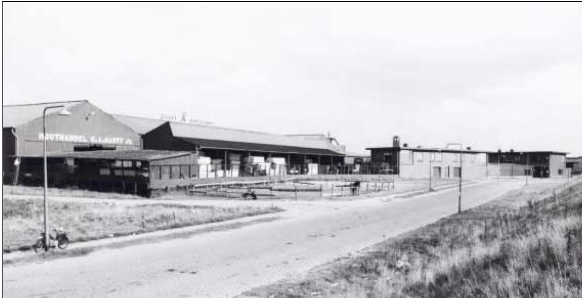
8 Houthandel Harff, ter plaatse van Solitudo, aan de Wenckebachweg in 1972 (foto SAA)
