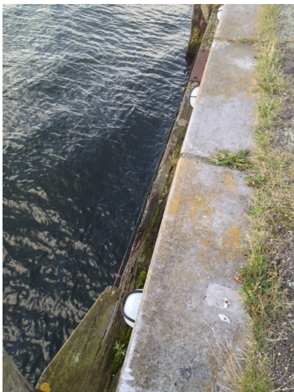
Natuurstenen dekplaten op de uiterst westelijke kademuur van het Java Eiland.
