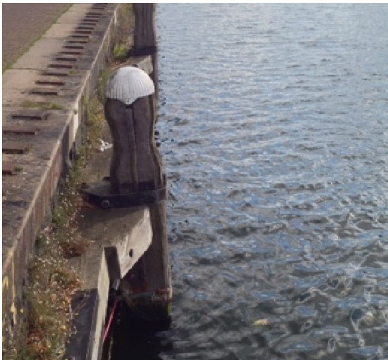
Voorbeeld van een laat negentiende-eeuwse meerpaal en aanvaarbescherming.
