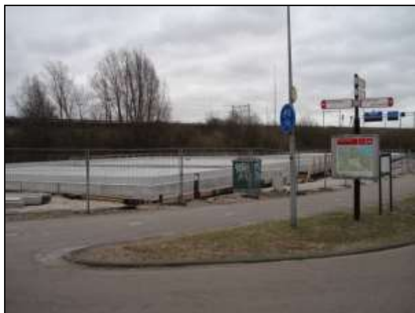
Afbeelding: aanlegwerkzaamheden bentoniet-scheidingsinstallatie
