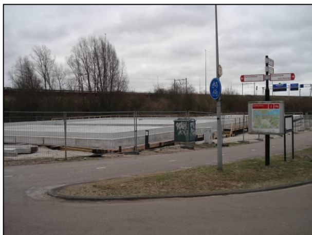
Afbeelding: aanlegwerkzaamheden bentoniet-scheidingsinstallatie
