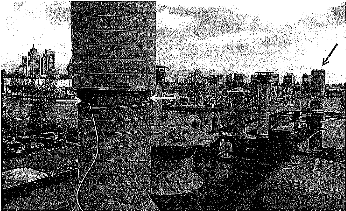
Figuur b: Meetlocatie schoorsteen verfspuitcabine. Met een blauwe pijl is ook het emissiepunt van de tweede spuitcabine weergegeven.
