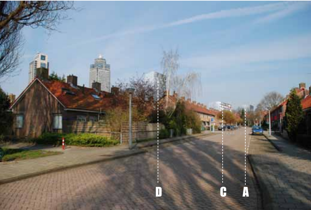
4 Zicht vanaf de Roosendaalstraat
