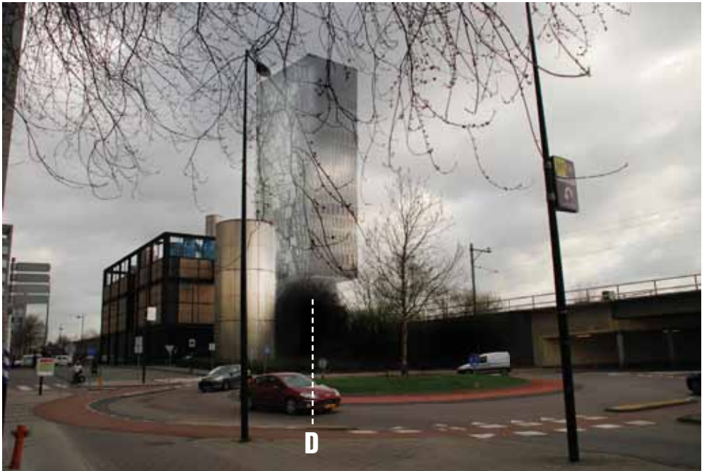
8 Zicht vanaf de rotonde Spaklerweg-Overzichtsweg. Toren A gaat schuil achter toren D.
