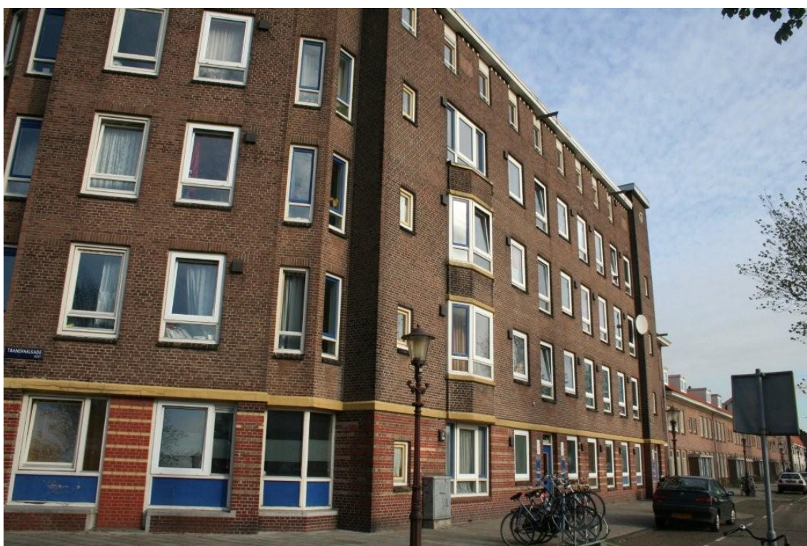
Foto 2 Zicht op het zuidelijke deel van de planlocatie: te slopen woningen
