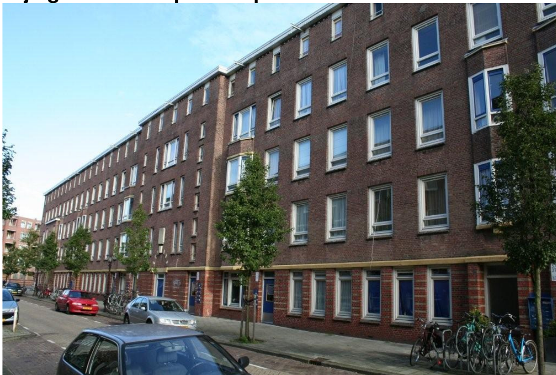
Foto 1 Zicht op het westelijke deel van de planlocatie: te slopen woningen.
