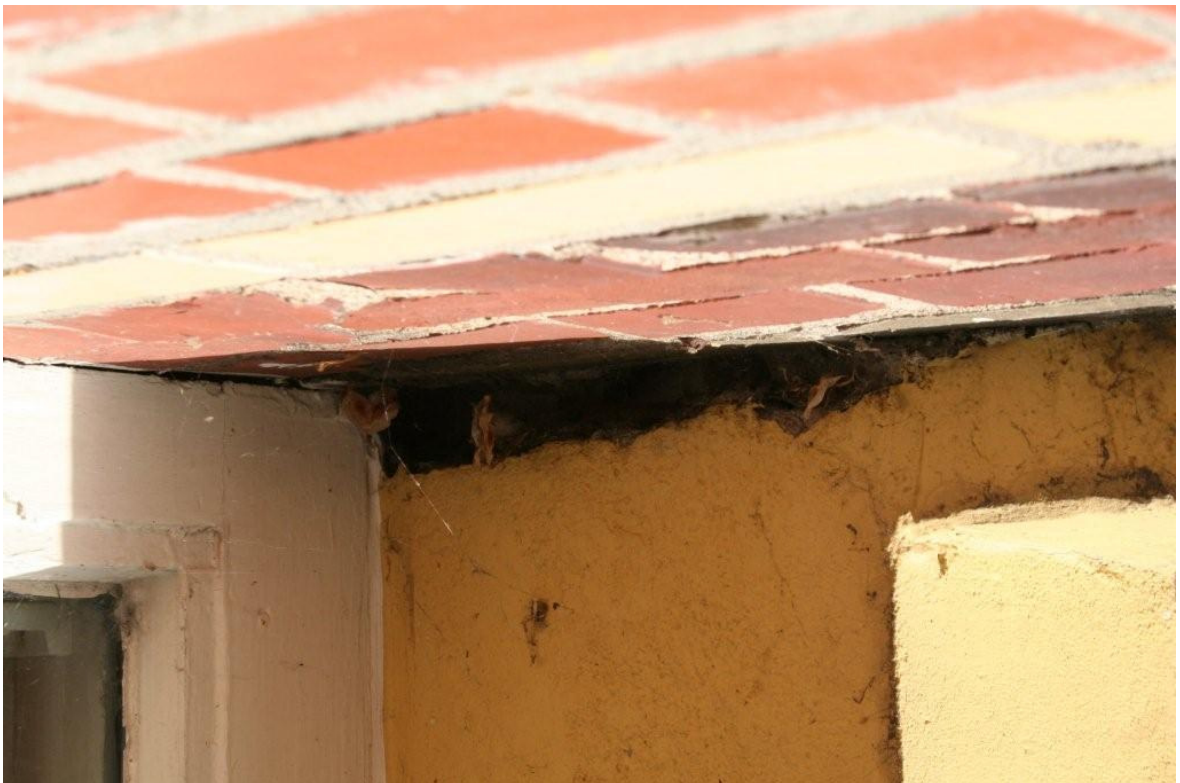
Foto 4 Zicht op kieren tussen de muur en omlijsting. Deze geven mogelijk toegang tot ruimten die door vleermuizen als een verblijfplaats kunnen worden gebruikt.
