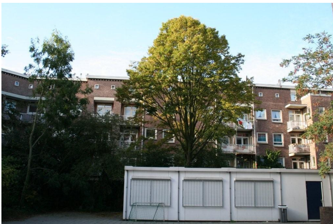
Foto 4 Zicht op het zuidelijk deel van de binnentuin
