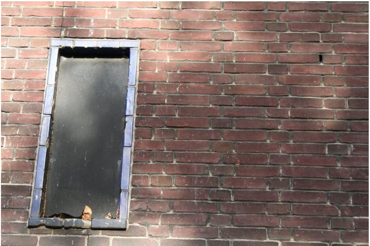
Foto 4 Zicht op kopse kant van de Kraaipanschool waar, achter de betimmerde ramen en in spouwvoegen, ruimten aanwezig zijn die mogelijk door vleermuizen kunnen worden gebruikt als verblijfplaats.
