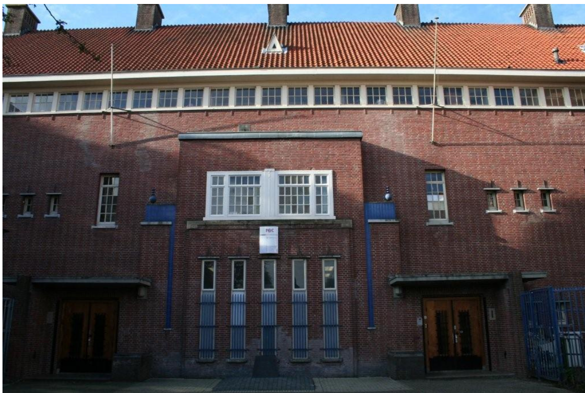
Foto 3 Zicht op noordelijk deel van de planlocatie: te renoveren Kraaipanschool
