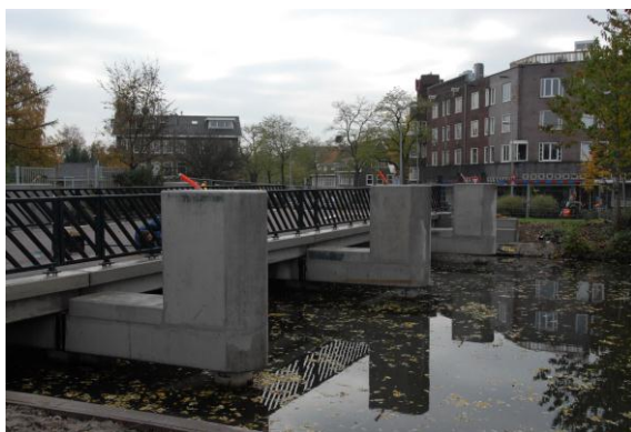
Gerealiseerde brug voor langzaamverkeer en calamiteiten
