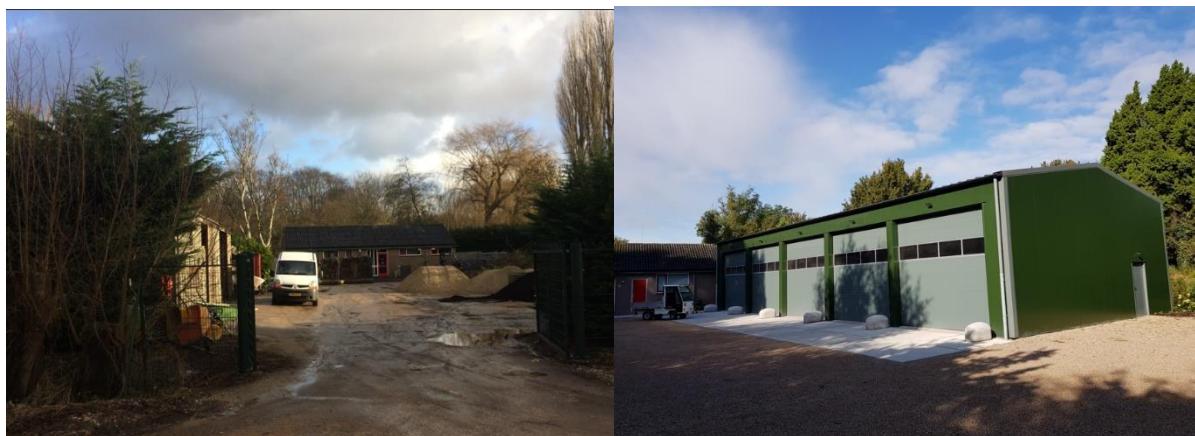
Afbeelding: het huidige werfgebouw vanuit westelijke richting (links) en de in 2022 gerealiseerde loods met links daarvan nog een deel van het bestaande werfgebouw (rechts)
