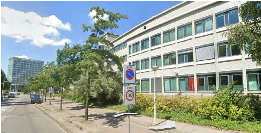
Afbeelding: huidige bebouwing projectlocatie
