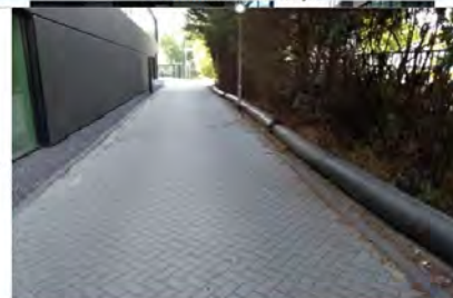
12. Westzijde gebouw G
