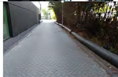
12. Westzijde gebouw G
