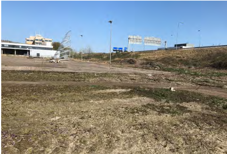
Figuur 2 Op het grootste gedeelte van de taluds is nauwelijks vegetatie aanwezig
