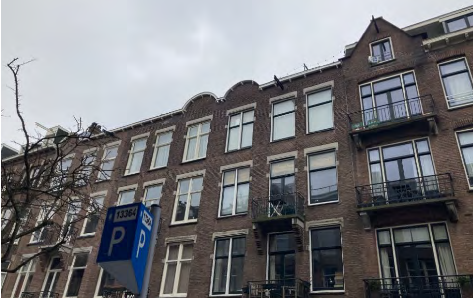
Gevelaanzicht vanaf de straat.
