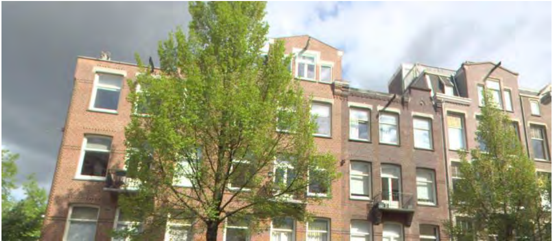
Joh. Verhulststraat 220-224. Nummer 222 is opgehoogd.
