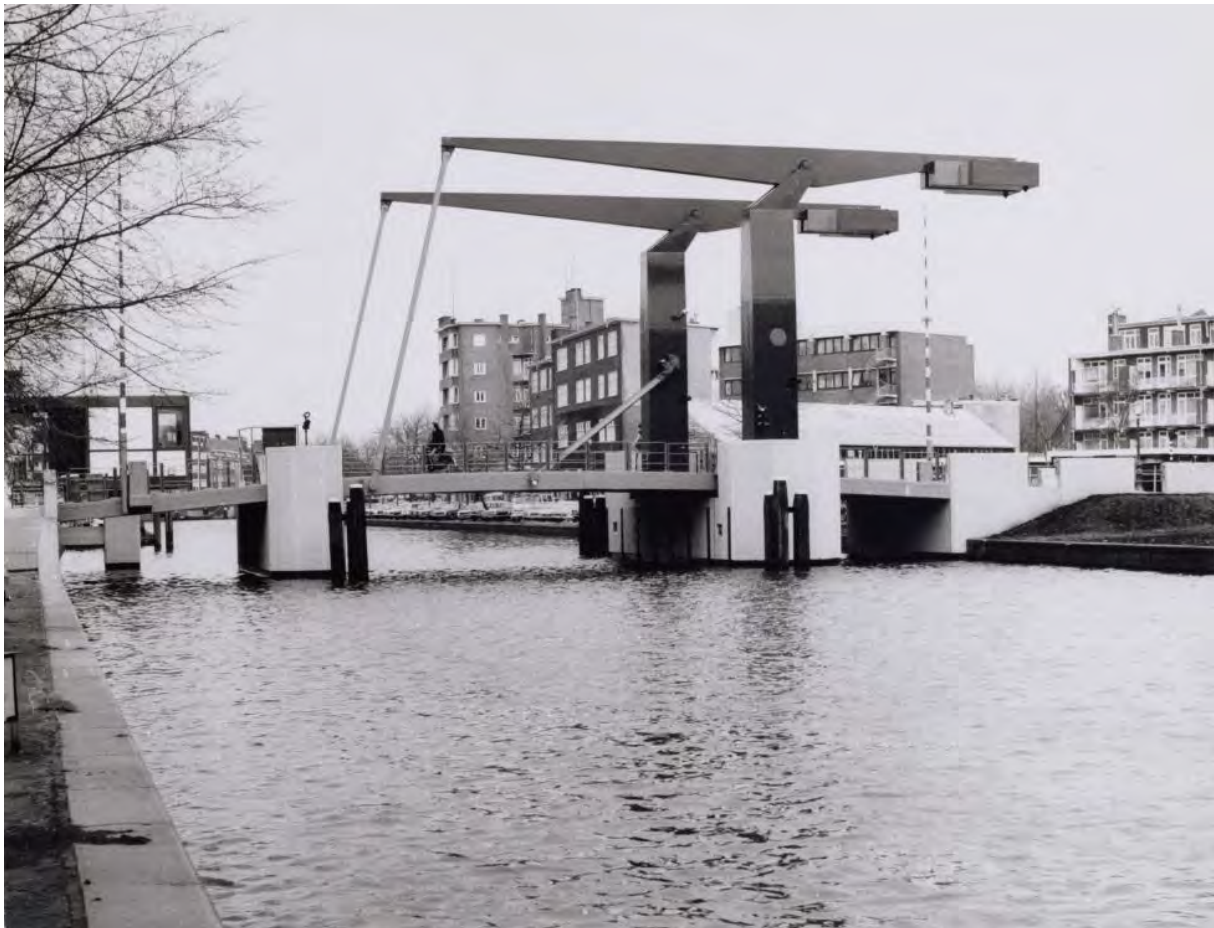
Afbeelding 85: Brug 360 over de Schinkel tussen de Schinkelhavenstraat en Theophile de Bockstraat. Uit SAA, B00000013843, 1976.
