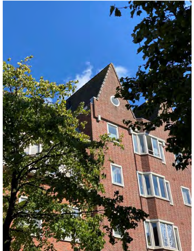
Foto bouwblok Stolwijkstraatzijde
