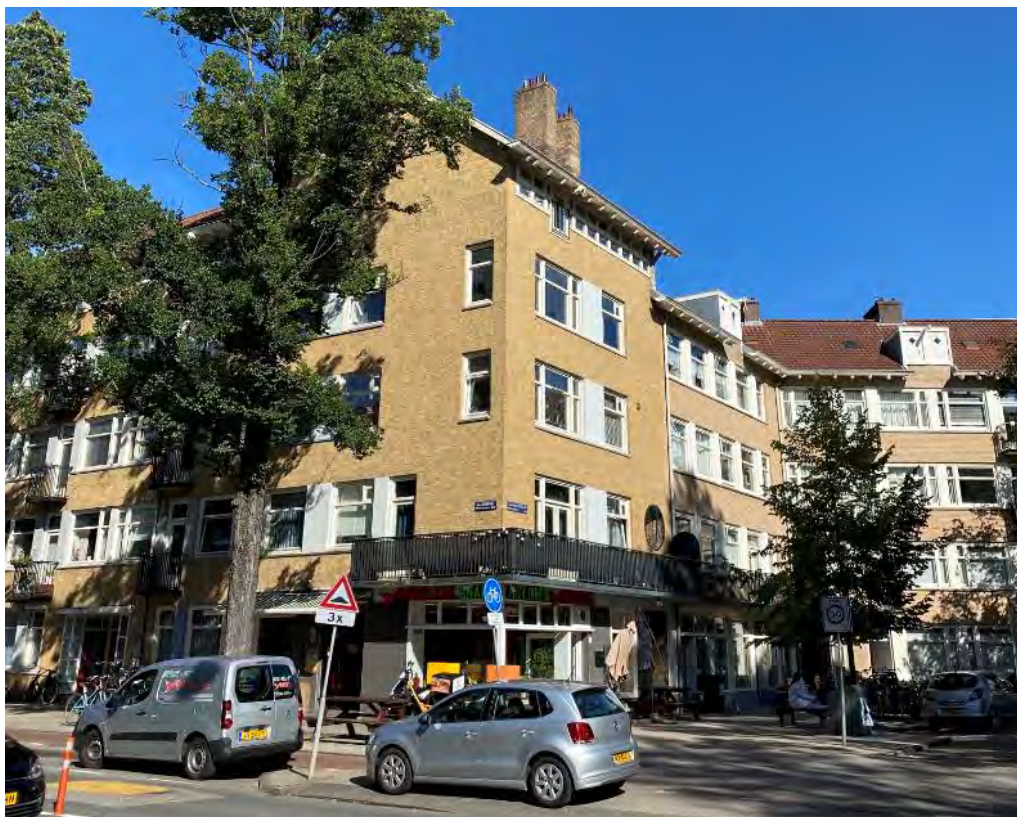
Hoekpand Aalsmeerweg / Sassenheimstraat. Doordat dit een bouwlaag hoger is dan de rest, zijn eventuele uitbouwen van de aangrenzende panden niet zichtbaar vanaf de straat. Bron: M&A, 18-8-2020.
