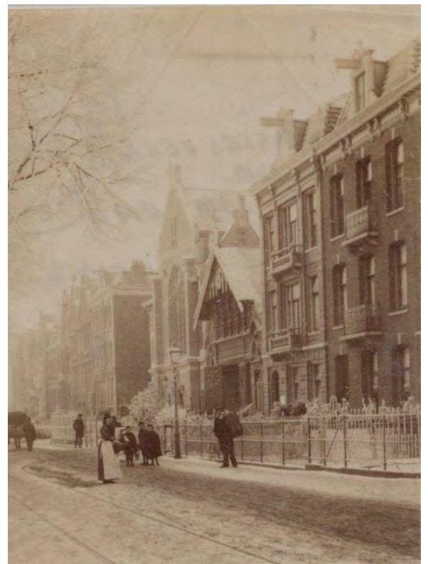
Afbeelding 16: De Amstelveenseweg gezien in zuidelijke richting. Het derde gebouw van rechts is de paardentramremise. Links ernaast, op de hoek met de Eerste Schinkelstraat, staat de in 1890 gerealiseerde Schinkelkerk.
