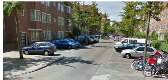
Talmastraat nu: de middenberm is vervangen door parkeerhavens, waardoor een wanverhouding tussen breedte van de straat en hoogte van bebouwing is ontstaan.
