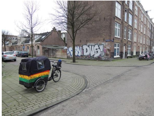
Aan de lage borstweringen op de begane grond is te zien dat het maaiveld een aantal keren is opgehoogd
