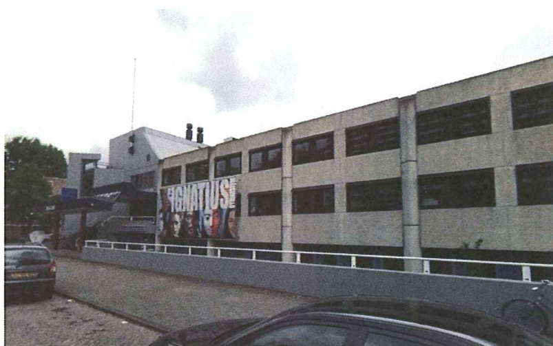
Gevelbeeld kantoorgebouw 'Offica II', de Klencke 4.
