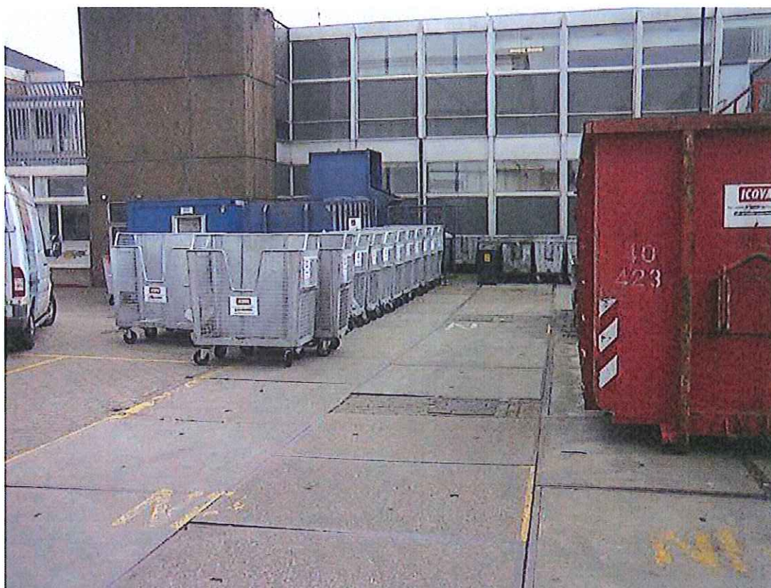
De noordzijde van deellocatie met stelconplaten. Links is boring 3 uitgevoerd
