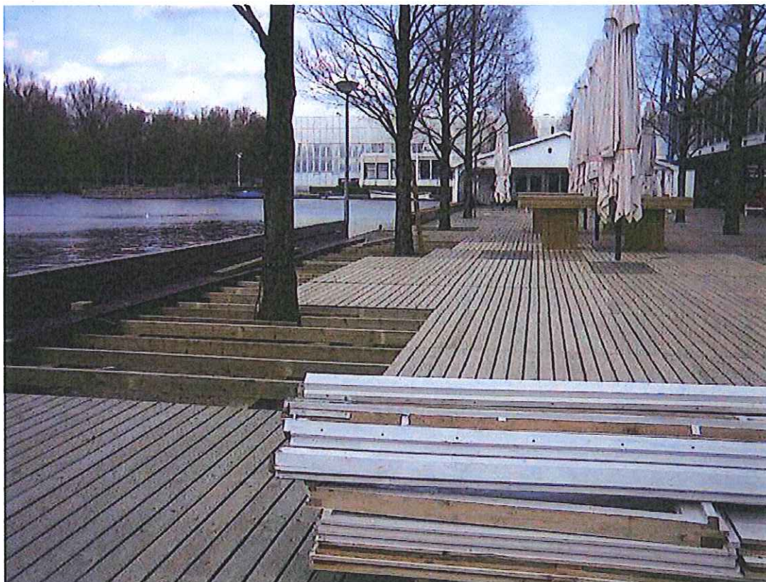
Deellocatie 1 (Westzijde) met tijdelijke bebouwing met vlonders en barretjes. Links deellocatie 2
