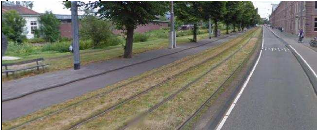
Figuur 4.2 Trambaan met grasbedekking
