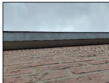
Figuur 10. Ruimte achter de daklijst van de aanwezige bebouwing.
