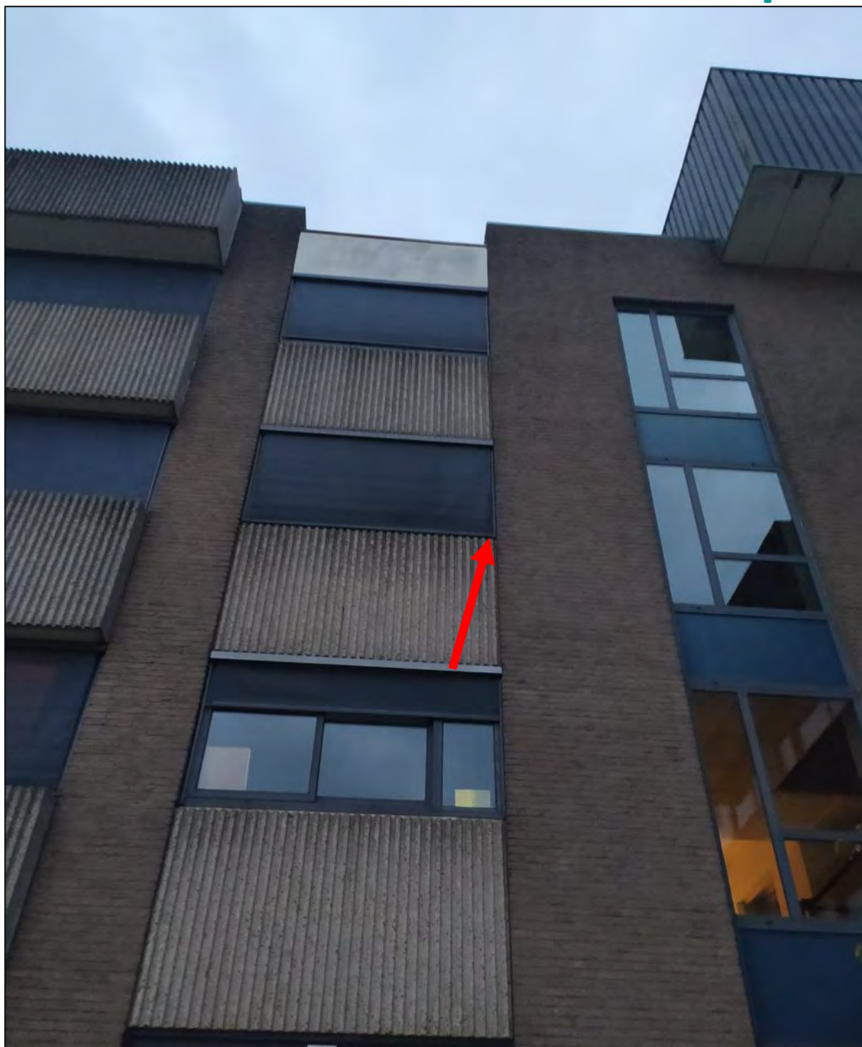
Figuur 4.3 Het vastgestelde vliegopening van paarverblijf bevond zich onder een raamkozijn (met rode pijl aangegeven).
