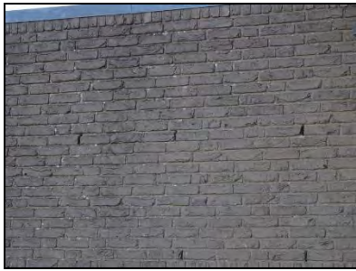
Figuur 11. Diverse stootvoegen in de gevels.
