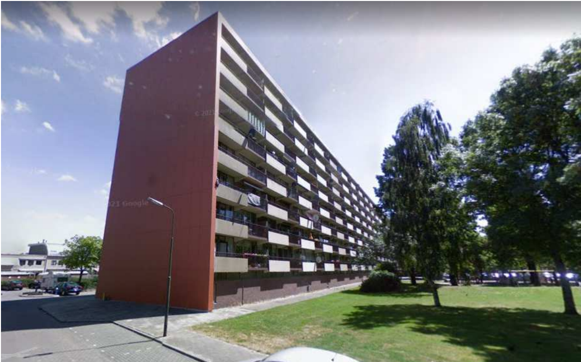
Figuur 3: De (gesloopte) flat aan de Kostverlorenstraat/Boternesserstraat, gezien vanuit noord, in juli 2008 (Google Street View, september 2022).
