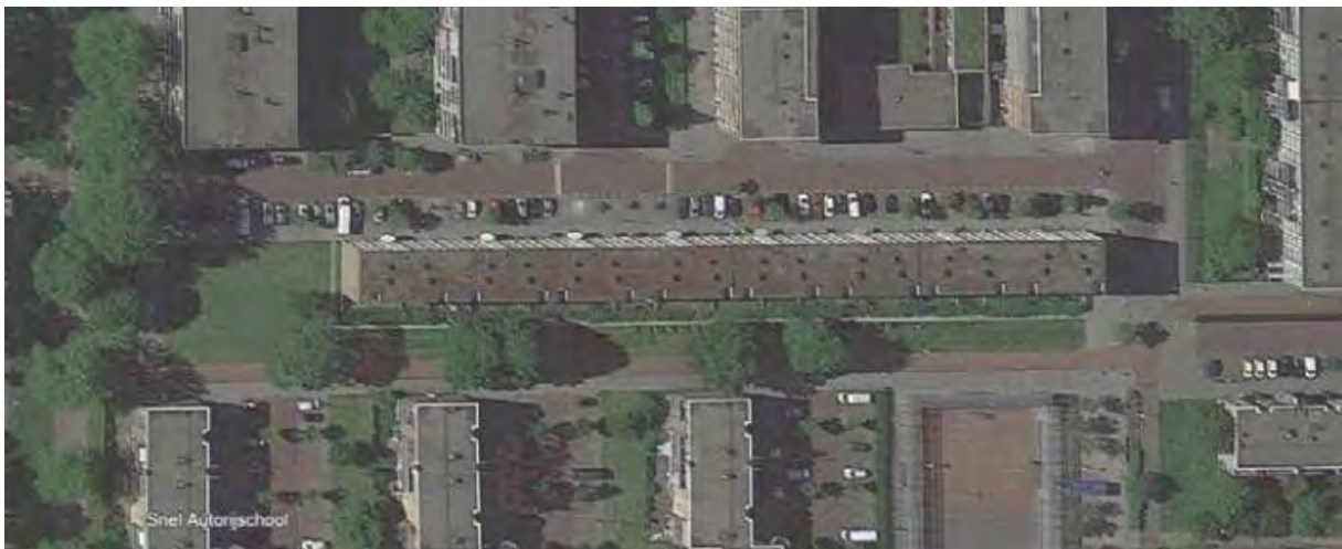
Bovenaanzicht van het gebouw aan de Nierkerkestraat
