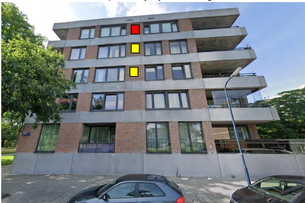
Figuur 7. Zuidgevel complex Baden Powellweg 36A tm 44D (kraamverblijf (rood) en/of zomerverblijven (geel))
