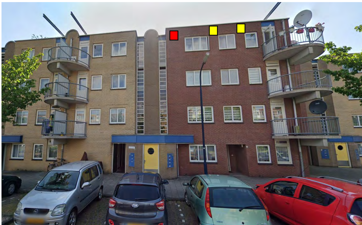
Figuur 10. Oostgevel complex Sam de Wolffstraat 1 tm 35 (kraamverblijf (rood) en/of zomerverblijf (geel))
