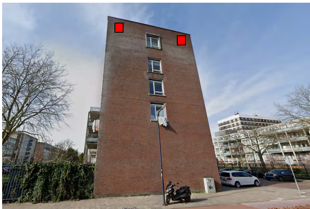
Figuur 8. Zuidgevel complex Hertingenstraat 42 tm 96 (kraamverblijven)
