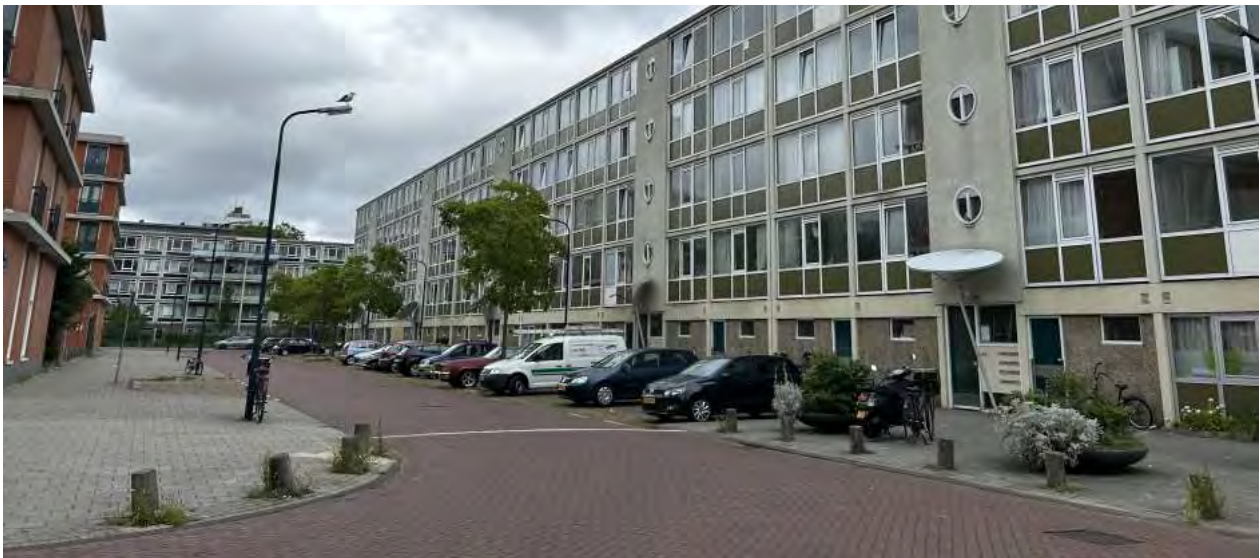
Figuur 1 Bestaand gebouw Nierkerkestraat (bron: Nierkerkestraat 1 t/m 55: vernieuwing woongebouw - Gemeente Amsterdam )
