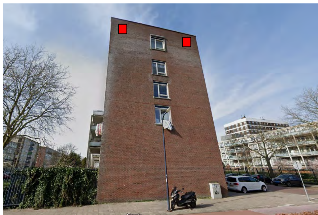
Figuur 8. Zuidgevel complex Hertingenstraat 42 tm 96 (kraamverblijven)
