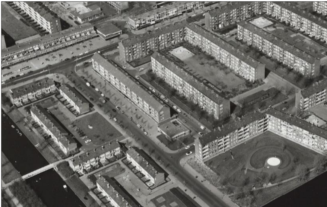
Afbeelding: luchtfoto van de Wildeman- en Blomwijckerbuurt uit 1973, gezien vanuit het zuiden (bron: beeldbank Amsterdam)
