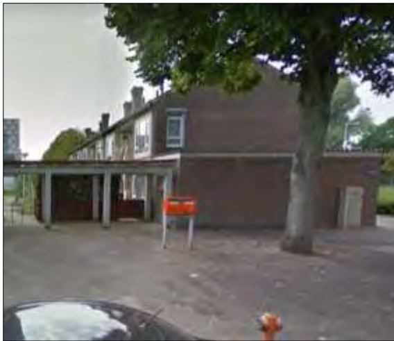
Afbeelding: bovenbenedenwoningen Osdorper Ban
