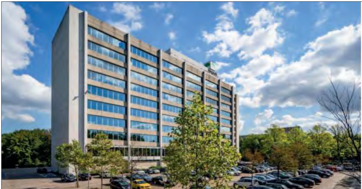
Afbeelding: de westgevel van het bestaande Ringparkgebouw voorafgaand aan de renovatie (bron: Ringparkkrant)
