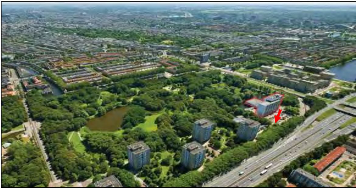
Afbeelding: het Ringparkgebouw, de projectlocatie en omgeving
