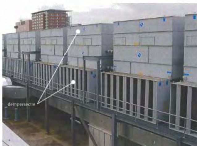
f7.1 Voorbeeld van getroffen voorzieningen aan bestaande bronnen
