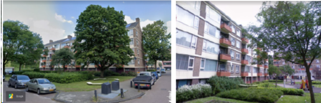
Afbeelding: impressie bestaande situatie (bron: Google earth)
