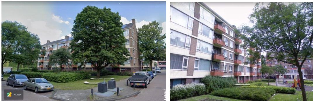
Afbeelding: impressie bestaande situatie (bron: Google earth)
