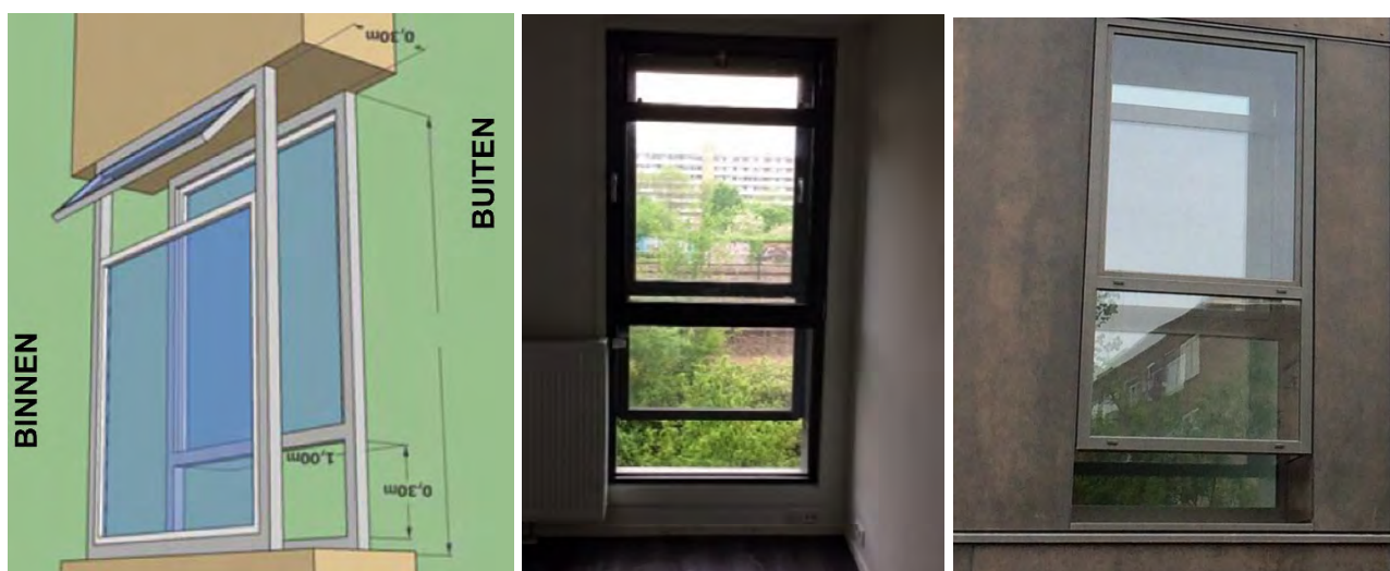
Figuur 5.1: Harbour Fenster – principe (links), binnenaanzicht (midden) en buitenaanzicht (rechts)
