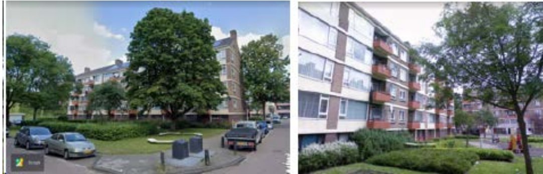
Afbeelding: impressie bestaande situatie (bron: Google earth)
