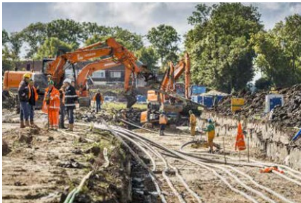
Figuur 7 - open ontgraving waarbij de kabels naast elkaar liggen
