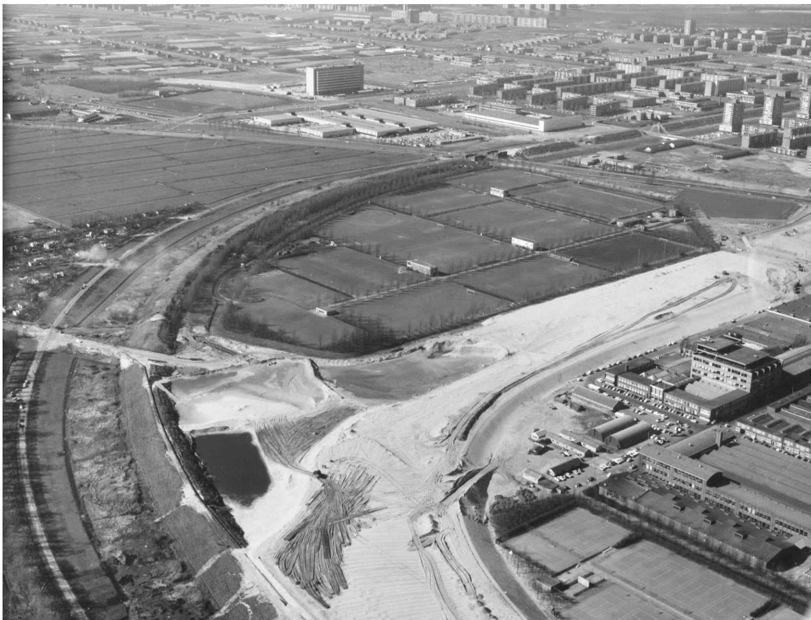
Luchtfoto uit 1968, met de aanleg van de A10 (rechts) en de Ringspoorlijn (links). In het midden achter ligt het IBM-terrein, langs de Oude Haagseweg. [Stadsarchief Amsterdam]
