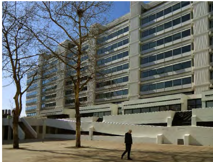
Boven: het (inmiddels gesloopte) hoofdkantoor van het CBS in Voorburg, 2000 en een maquette van het gebouw uit 1968. [Haags Gemeentearchief]
