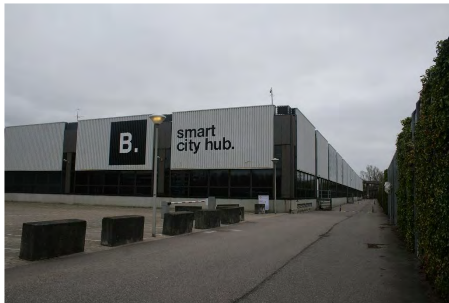
Het tweede IBM-fabriekscomplex met de parkeerplaatsen op het dak, de gevels met glaspuien en golfplaten, die boven het dak uitsteken. Aan de binnenkant de draagconstructie met betonnen ribcassetteplafond.
