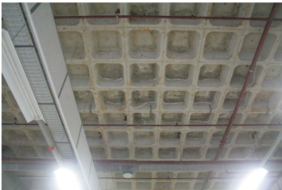
Het tweede IBM-fabriekscomplex met de parkeerplaatsen op het dak, de gevels met glaspuien en golfplaten, die boven het dak uitsteken. Aan de binnenkant de draagconstructie met betonnen ribcassetteplafond.
