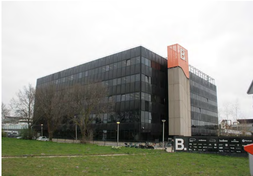
Boven: het voormalige administratiegebouw in 2021.
