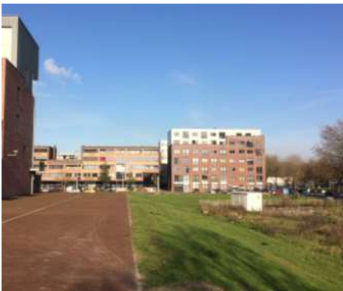
Afbeelding: Talud westzijde projectlocatie
