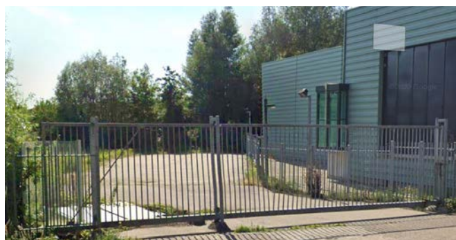
Bestaande poort (hoofdontsluiting)
