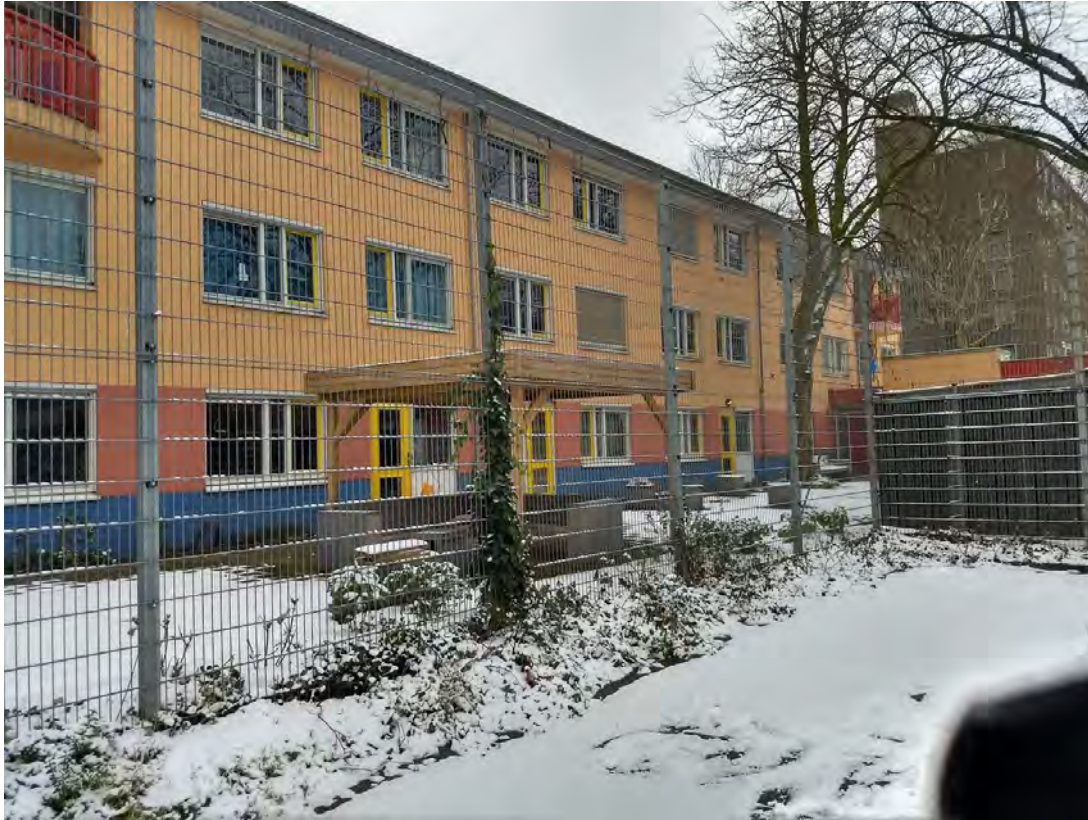
figuur 6: Achterkant gebouw leger des heils
