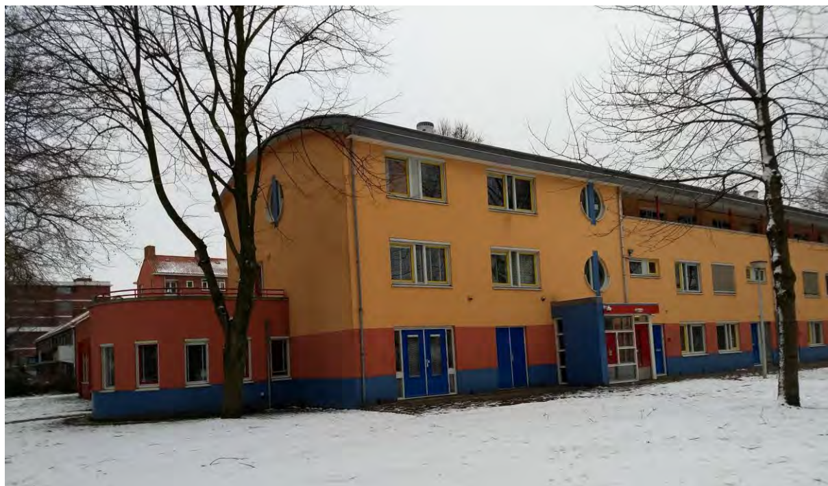
figuur 5: Gebouw van het leger des Heils
