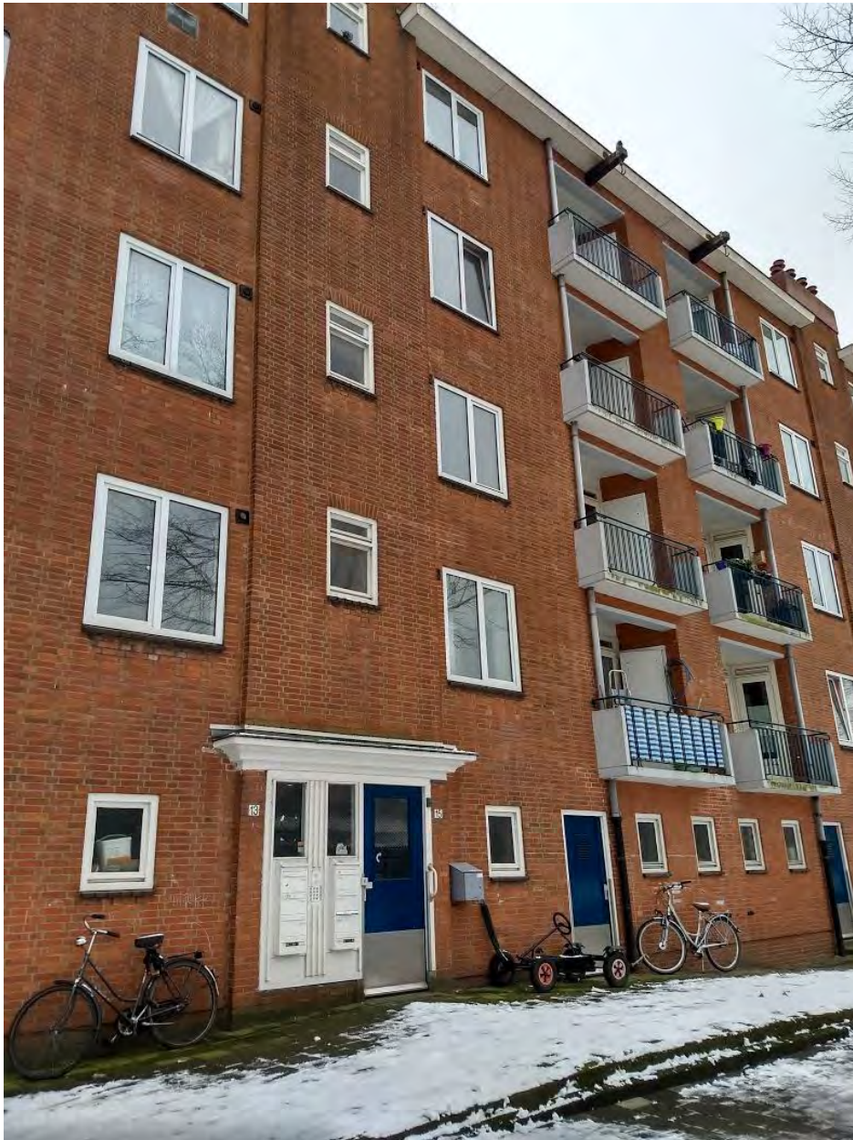
figuur 8: Zijkant flatgebouw
