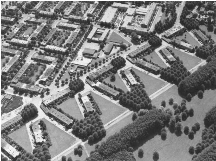
Afbeelding 27: Woonhoven langs het Sloterpark, aan de Bakhuisen van den Brinkhof / Hemsterhuisstraat, in oostelijke richting gezien, 1987. Uit: SAA, B00000037892.
