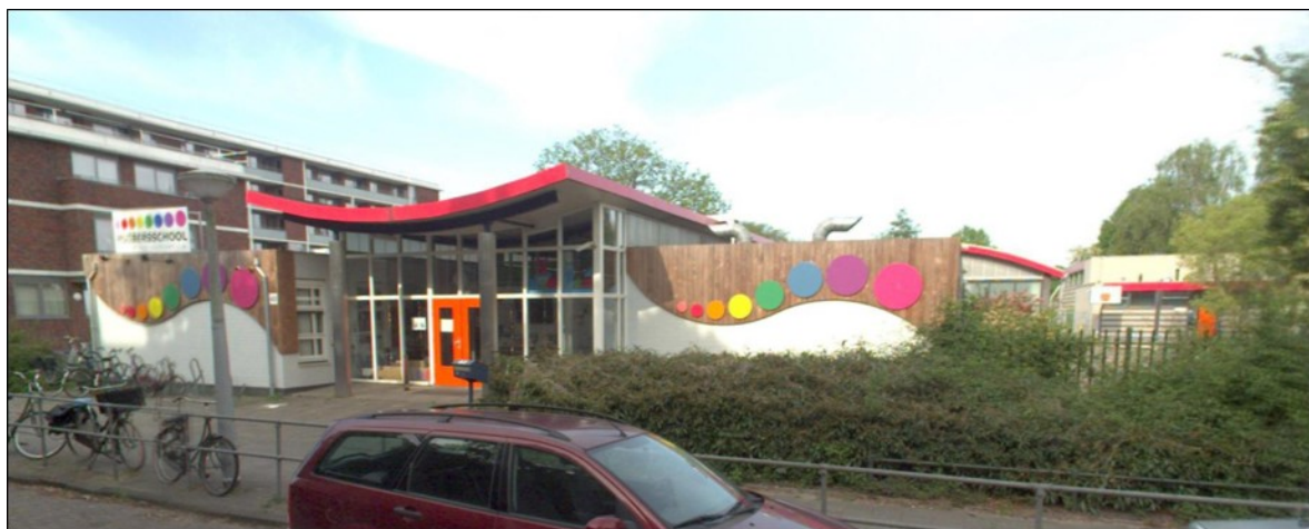
Afbeelding: het basisscholencomplex ten westen van het plangebied, gezien van de Jacob Geelstraat (bron: https://www.maps.amsterdam.nl/ )
