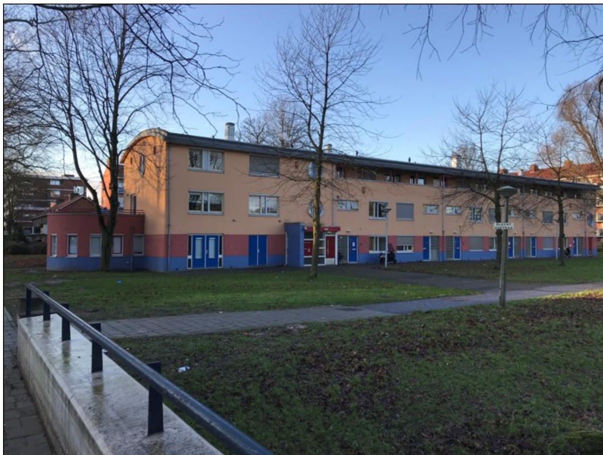
Afbeelding: de ten zuidoosten gelegen bebouwing van het Leger des Heils aan de Comeniusstraat
