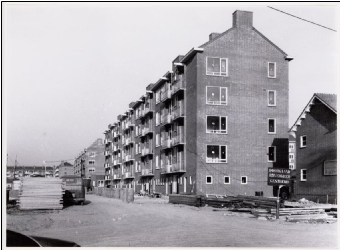
Afbeelding: de bebouwing langs de Jacob Geelstraat in december 1957 vlak voor oplevering, ter hoogte van de kruising met het Hermanus van der Tuukhof (bron: Beeldbank Amsterdam)
